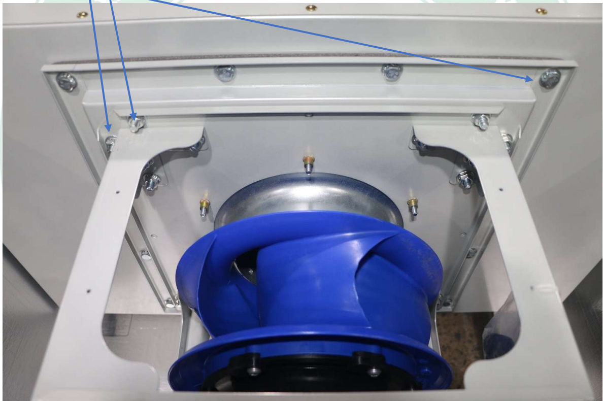
Fig. 15 — Remove 8 nuts securing the fan
